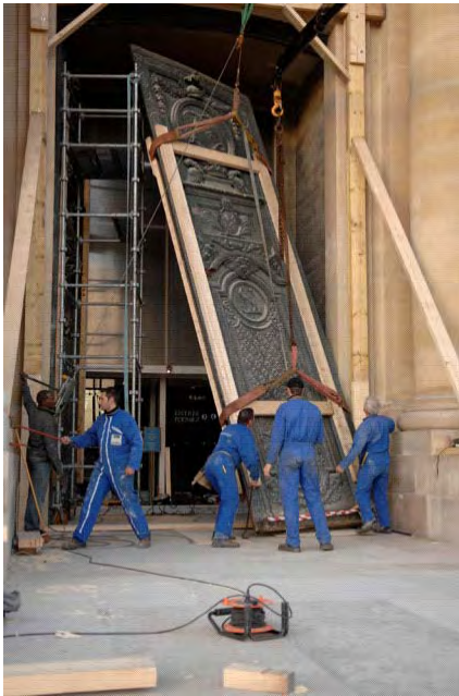
Décembre 2007, démontage des portes du Dôme par les ateliers Aubert-Labansat.
